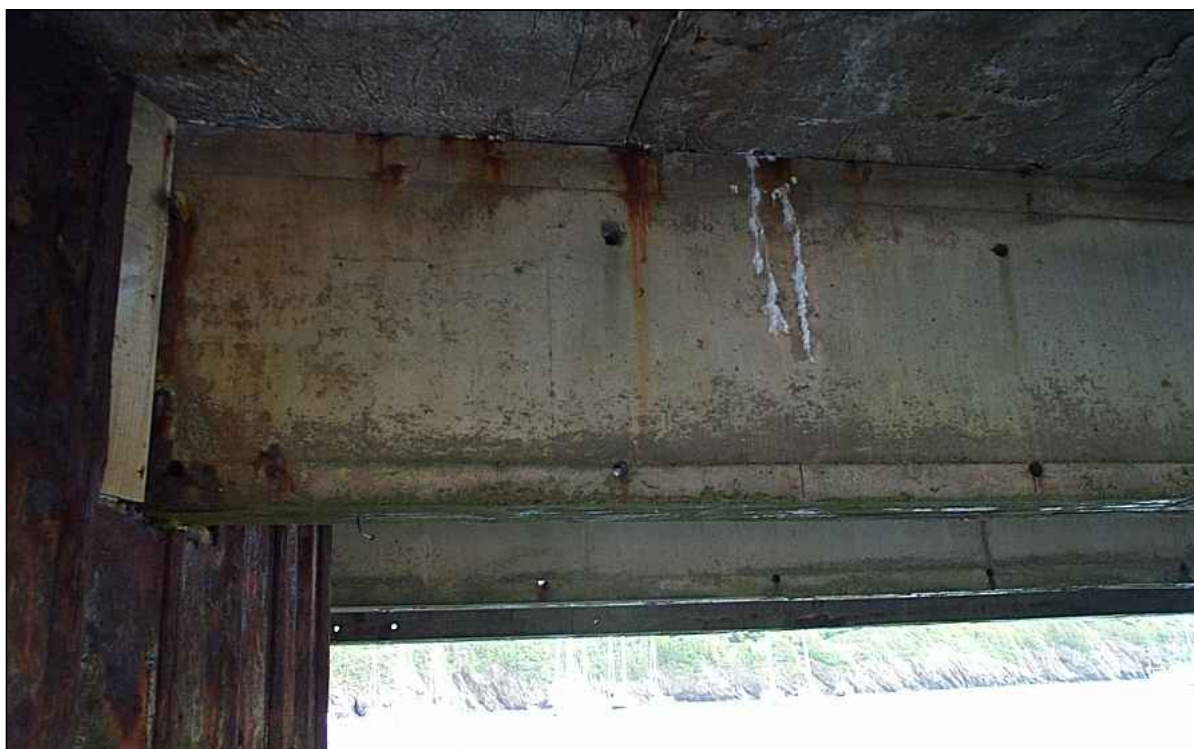
▼ Photo n°17 : Altération des poutres béton
