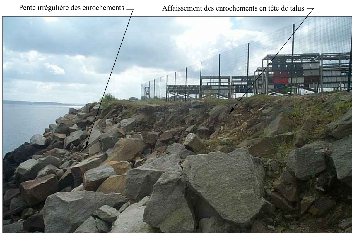
▲ Photo n°18 : Affaissement des enrochements
