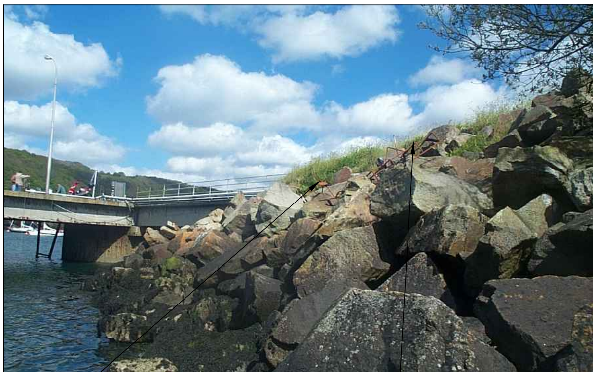
← Affaissement des enrochements en partie haute
