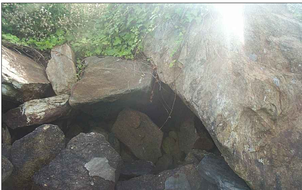
▼ Photo n°8 : Affouillement et lacune en partie supérieure des enrochements
