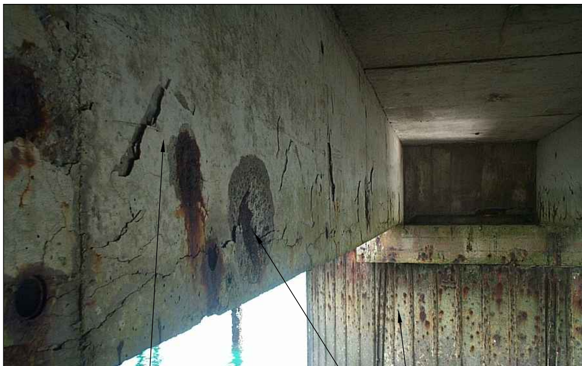
▼ Photo n°15: Détérioration importante des poutres en béton armé
