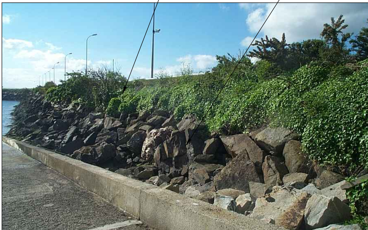
▲ Photo n°1 : Détérioration des enrochements au niveau de la cale
