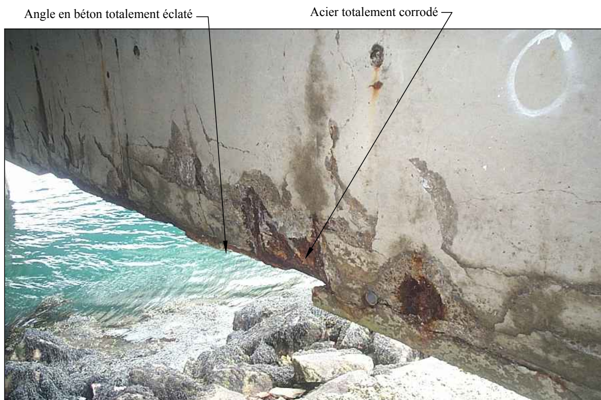
▲ Photo n°16 : Eclatement important des poutres béton
