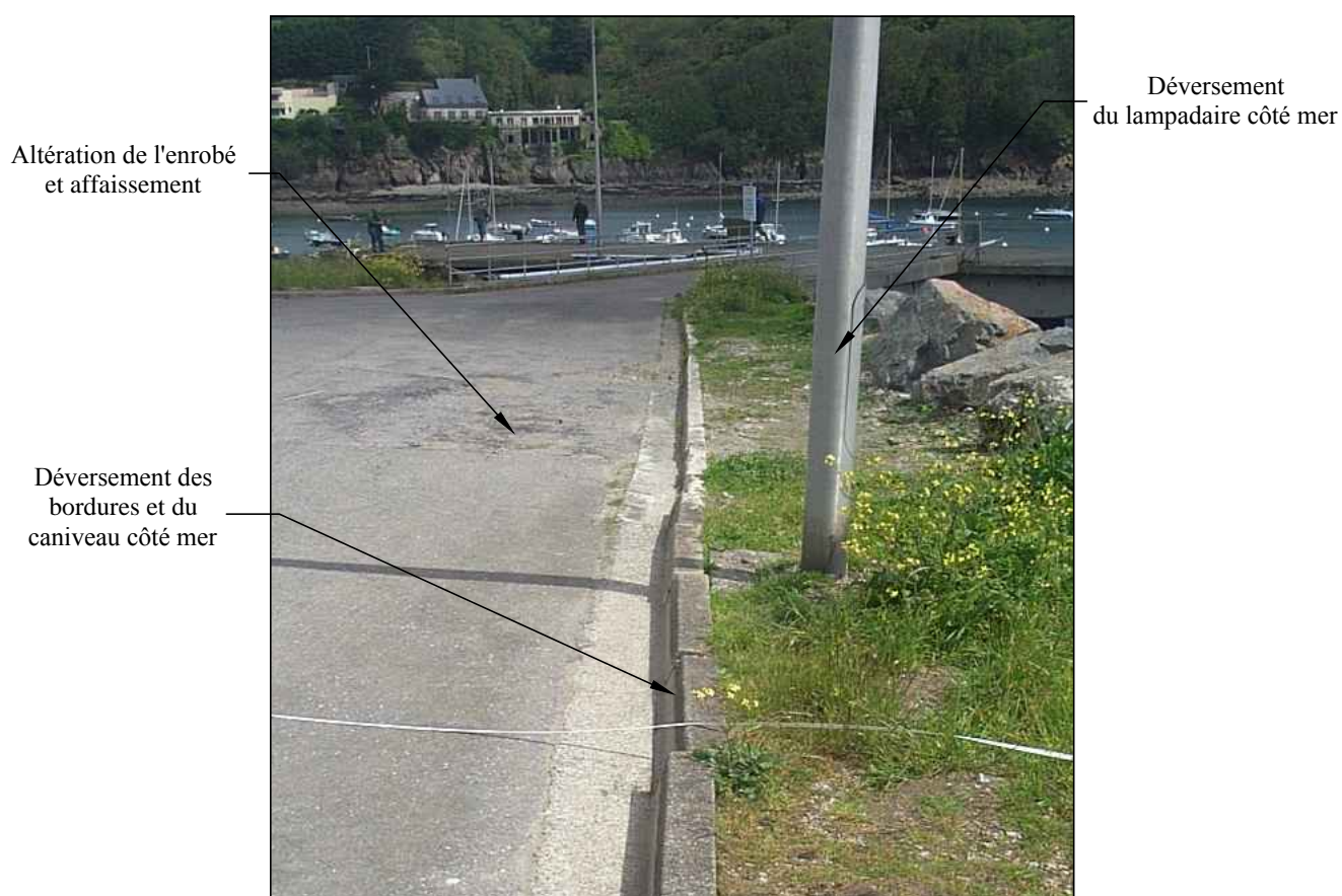
▲ Photo n°10 : Détérioration de la chaussée à proximité de la passerelle
